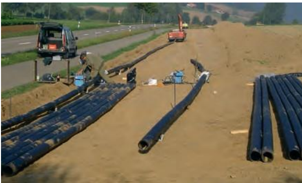
Abwasserdruckleitung aus PE 100 als Zuleitung zur Abwasserreinigungsanlage
