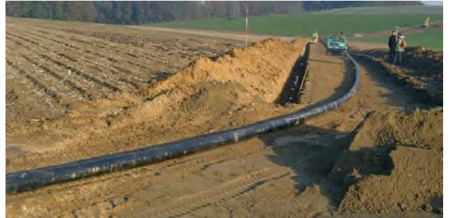
Abwasserdruckleitung aus PE 100 als Zuleitung zur Abwasserreinigungsanlage
