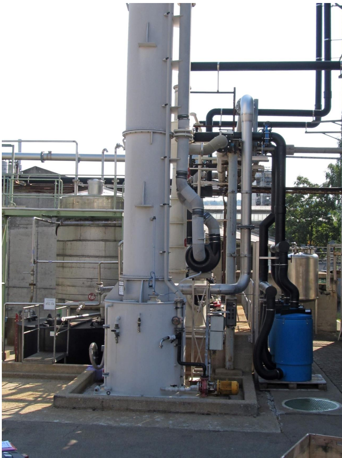
Chemieabluftwäscher aus PP mit Waschwasservorlage und integriertem Tropfenabscheider
