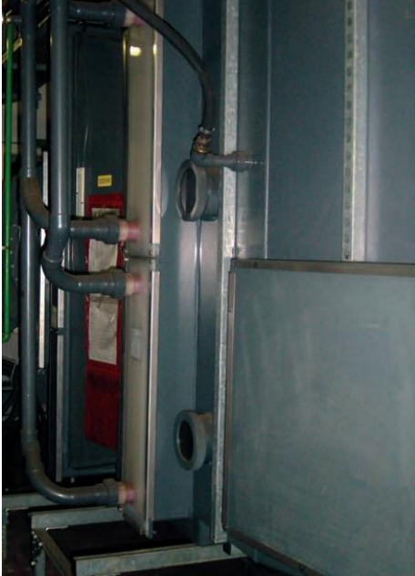
kpl. Abluftbehandlungsanlage aus PVC für Galvanikabluft mit Filtern in Schubladenbauform
